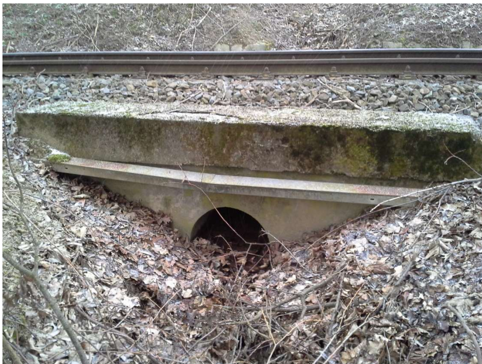
Foto 3: Pohled na zanesenou výtokovou stranu propustku
