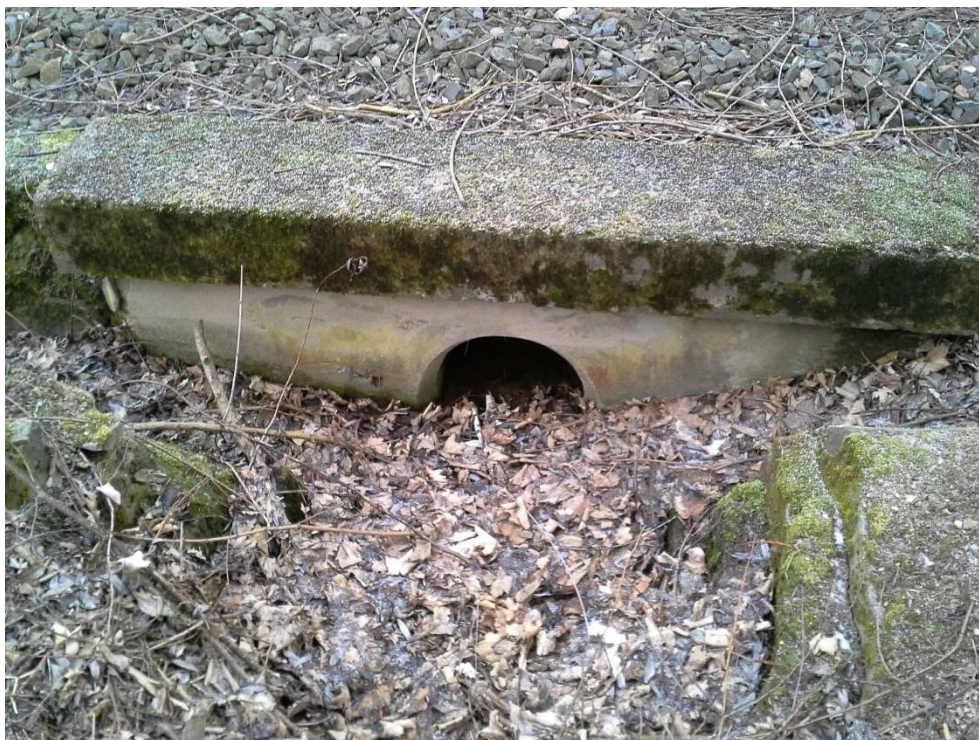
Foto 1: Pohled na zanesenou vtokovou stranu propustku
